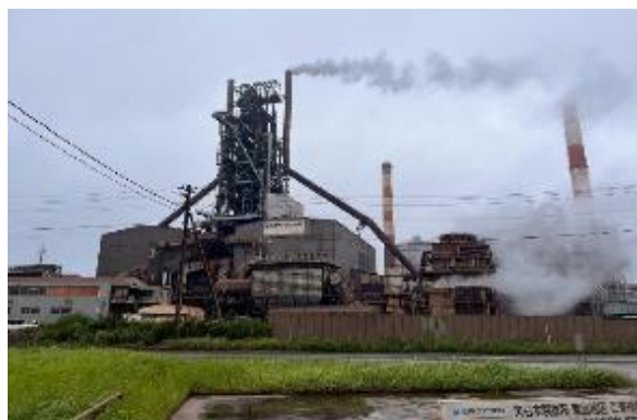
日本製鉄株式会社東日本製鉄鹿島地区
